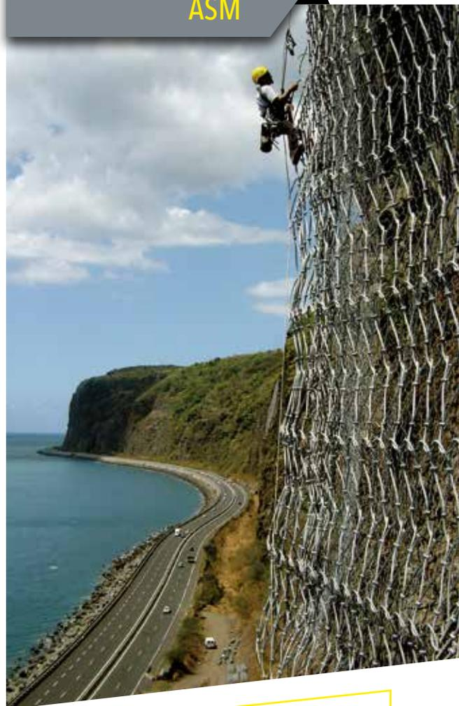
Le **grillage plaqué** est placé contre la paroi rocheuse afin de contenir la chute de blocs.
