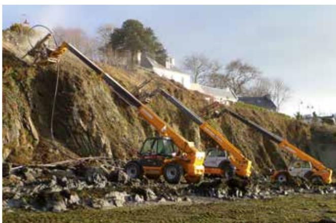
L'action de **forage** consiste à forer la paroi rocheuse afin d'y sceller des tirants d'ancrage ou des clous
