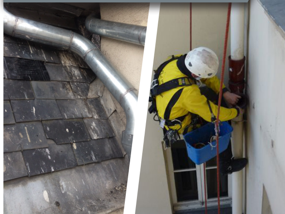
RÉFECTION DESCENTES EAUX PLUVIALES (ZINC, FONTE, ...)
