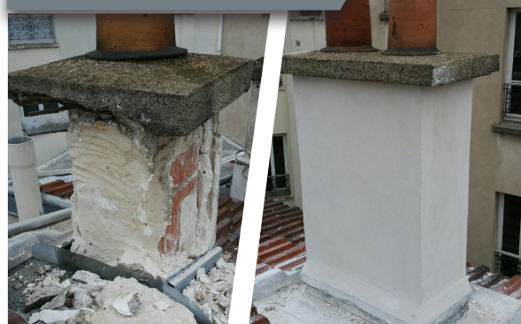
RÉFECTION SOUCHE CHEMINÉE
