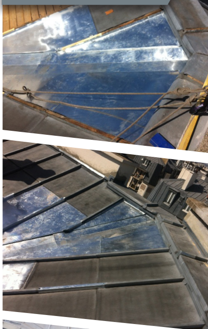
RÉPARATION PONCTUELLE ZINC
